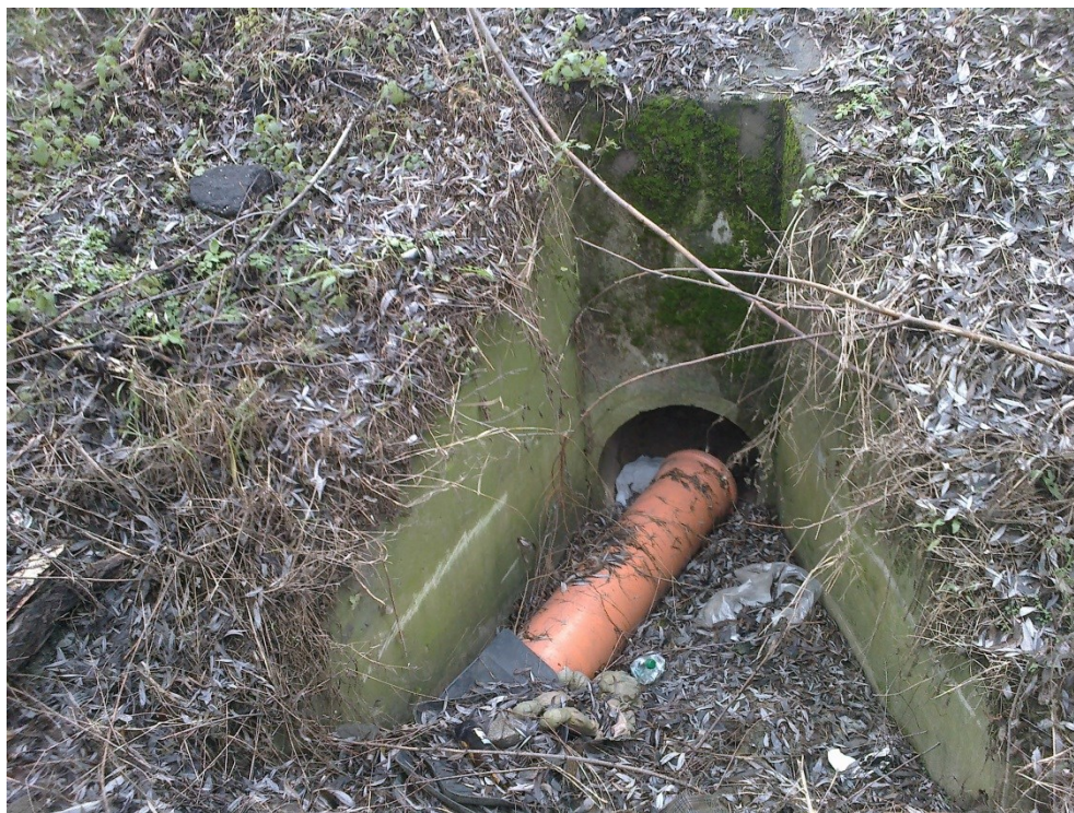
Zdjęcie 1. Początek rowu melioracyjnego „S – 7” („R-E”), przepust w Alei 700-lecia - wylot
